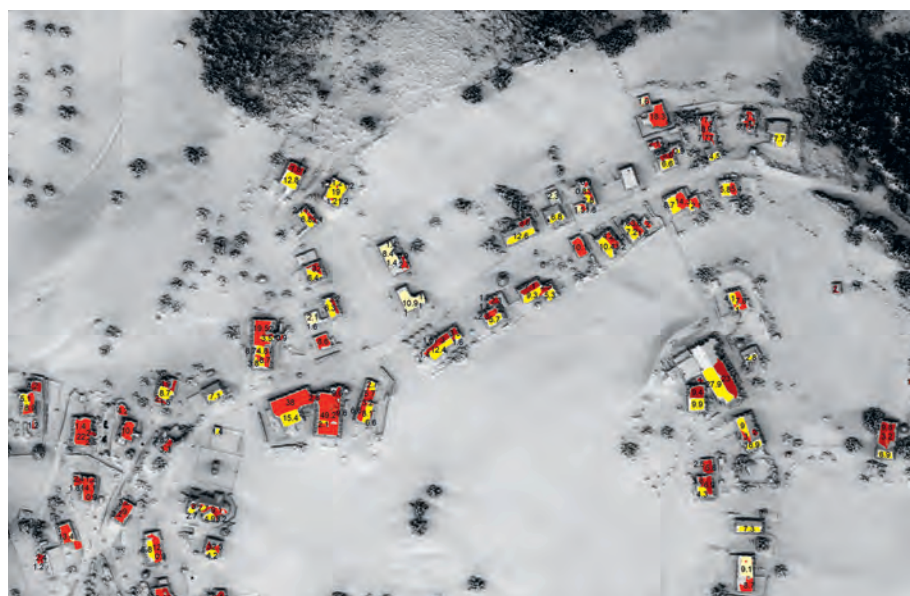
Solarkataster der Gemeinde Zwischenwasser liefert Basisdaten für einen Energiemasterplan: Es kann 1.5 Mal mehr Strom pro Jahr erzeugt werden, als in der Gemeinde benötigt wird.
