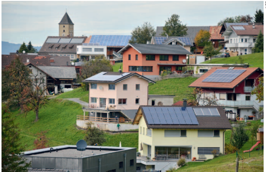
Photovoltaik in Zwischenwasser.
